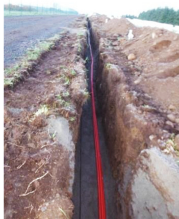
FOTOGRAFIA 3 – Exemplo de vala para instalação de cabos elétricos.
